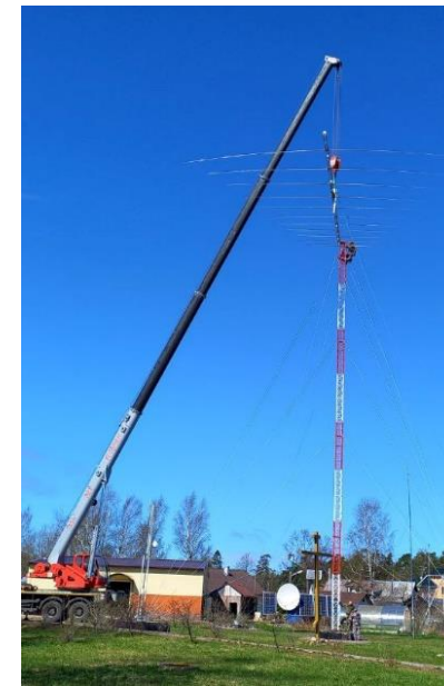
Установка антенн возвратно-наклонного зондирования
